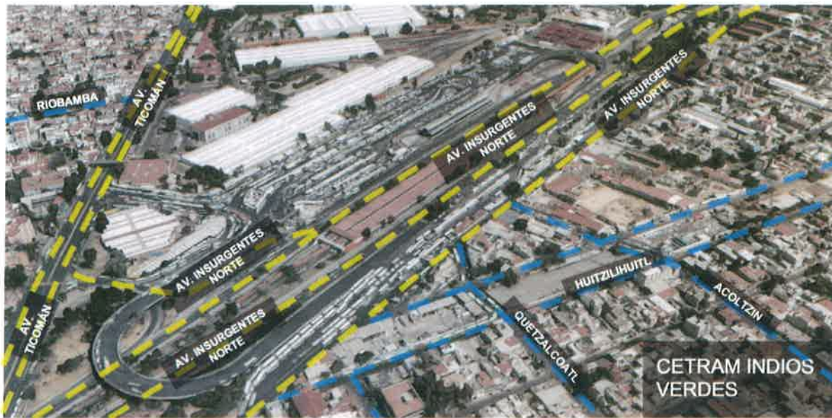
Figura I.5 Vialidades que rodean al CETRAM Indios Verdes. Fuente: Elaborado por el ORT 2019.
